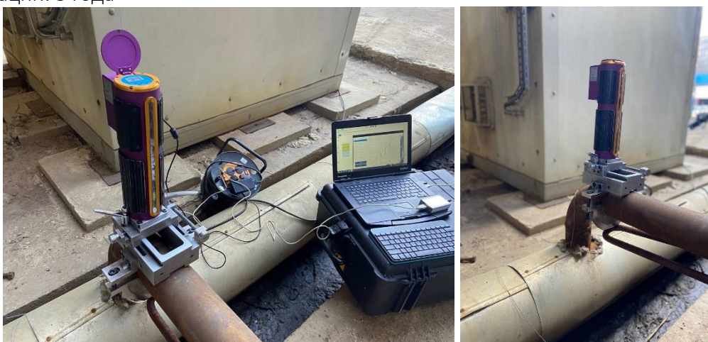
Рисунок 9 - Испытание металла элементов технологической линии л.100.45d.72.00.DB03.
